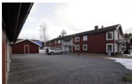
RAUFOSS: Elvesvingen 30 borettslag har åtte beboere og ble bygd i 1996. (Foto: Vidar Fristlie)
